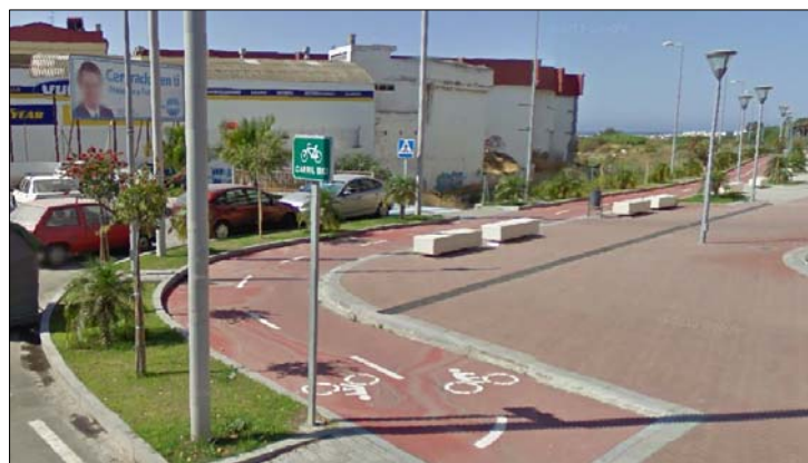
Señalización de carril bici
